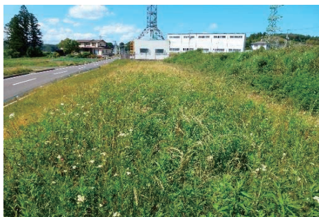
展望地（道路脇の盛土）の状況
