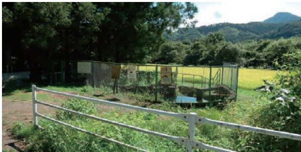
分水工の全景
