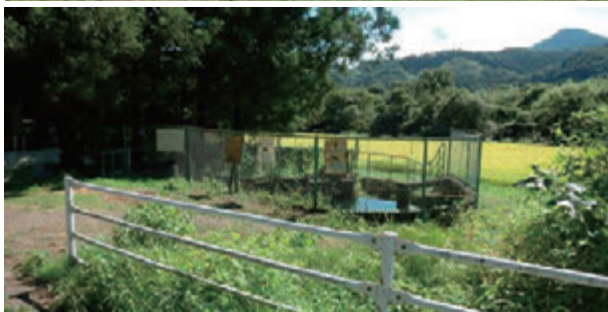
分水工の全景
