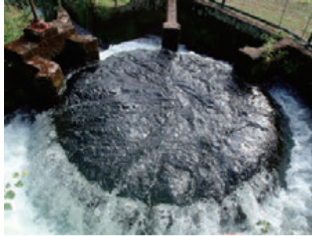
疣岩分水工 (水力発電に利用した水をサイフォンで対岸に導水し分配)
