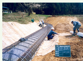
澄川用水路の改修工事の様子
