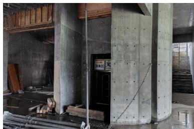
1 階のエレベーター。各部屋の形もわかるようになってきました。
