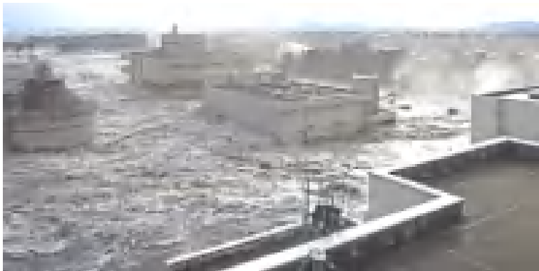
3/11 仙南浄化センター(下水道処理施設)に押し寄せる大津波 (写真提供：宮城県土木部)
